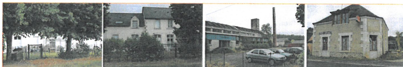
Bâti témoin des activités industrielles de la Fuye (petit collectif des ouvriers, maisons des contremaître, cheminée de l'ancienne laiterie, ancienne gare)
